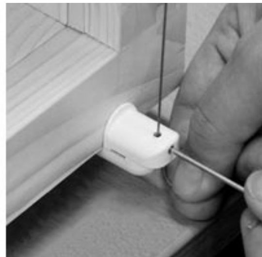
3. vastzetten spankabel
